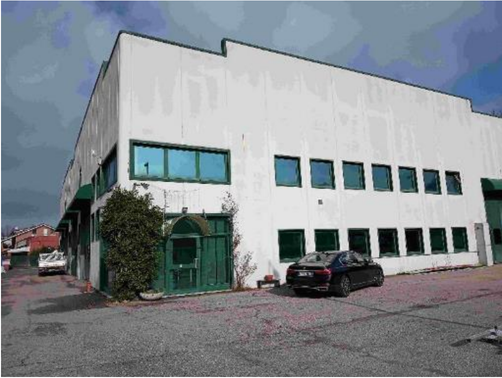
Foto 3 Vista lato sud – ingresso uffici
