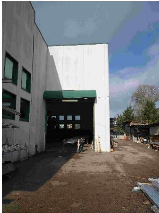
Foto 10 vista lato torrente Borbore
