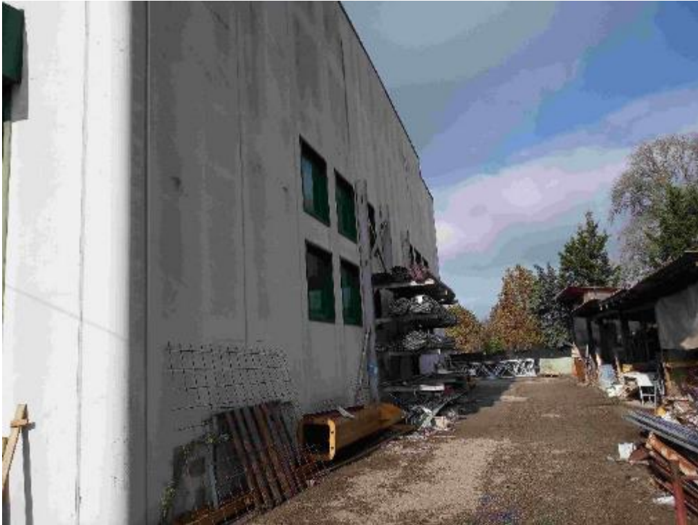
Foto 11 porzione lato est torrente Borbore
