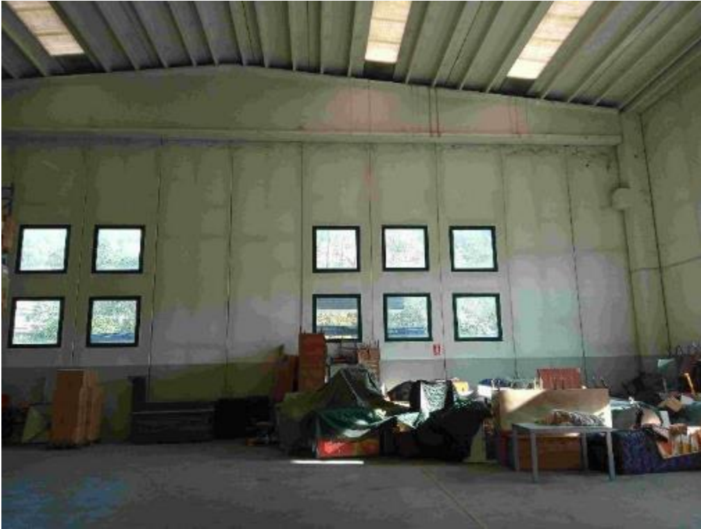
Foto 25 Interno capannone settore sud (verso parete est)
