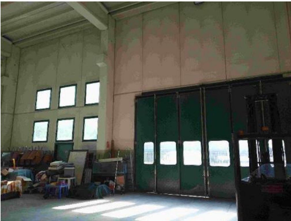
Foto 26 Interno capannone settore sud (verso parete sud)
