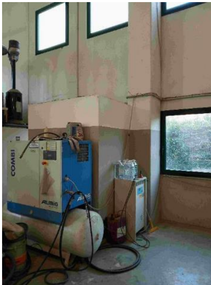
Foto 30 settore nord (wc non autorizzato)
