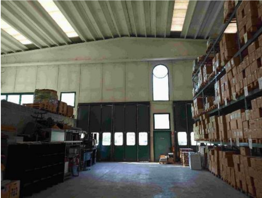
Foto 27 settore sud (verso parete ovest)
